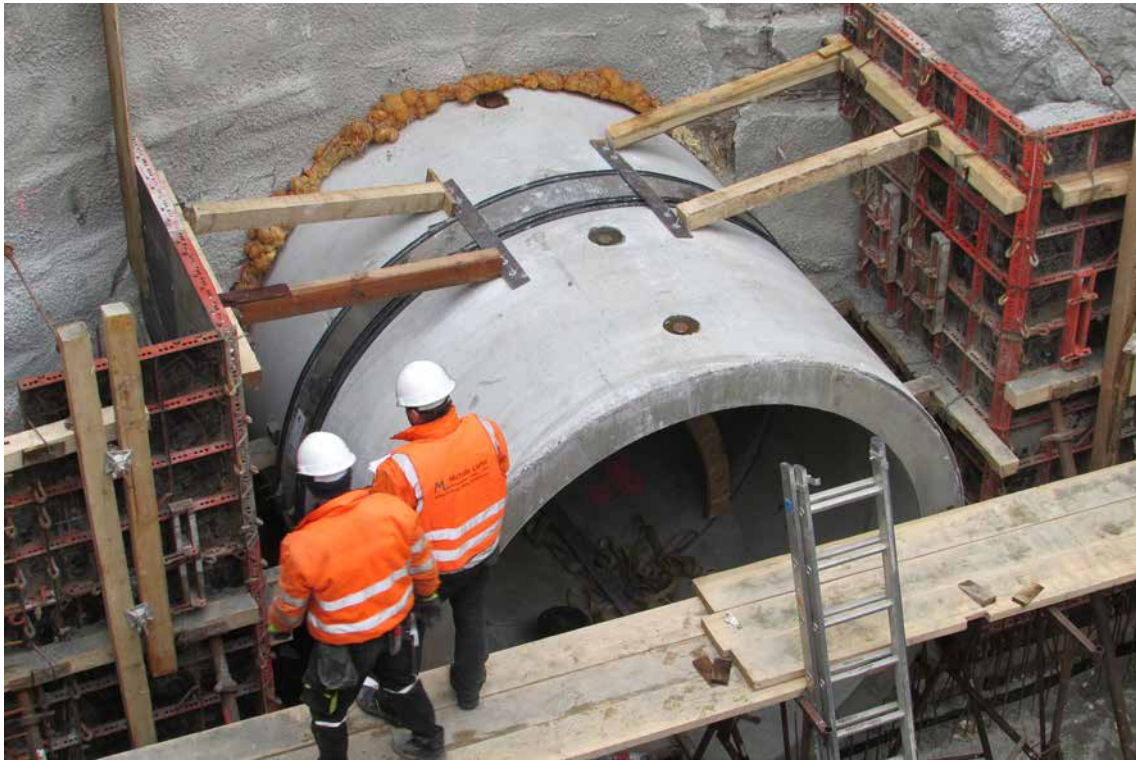
Passtück und Vortriebsrohrstrang in DN 2800 zielsicher miteinander verbunden: Die eingebaute Canada TITAN XL Kupplung sorgt neben den Stahlankern zusätzlich für die Lagesicherung des Passtückes.
