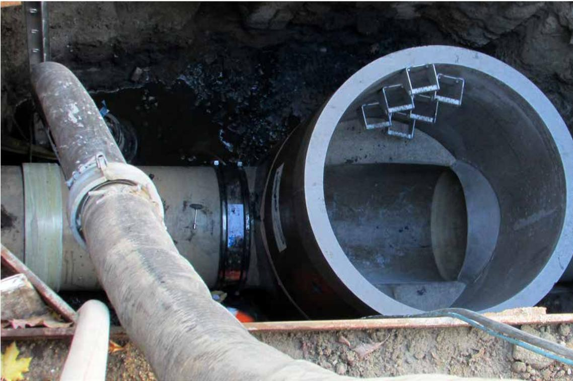
Eine dichte Verbindung: Die fertig montierte Übergangskupplung verbindet GFK-Passtück mit dem bauseits am Polymerbetonschacht eingebautem GFK-Anschlussstutzen DN 800 sicher und zuverlässig.
