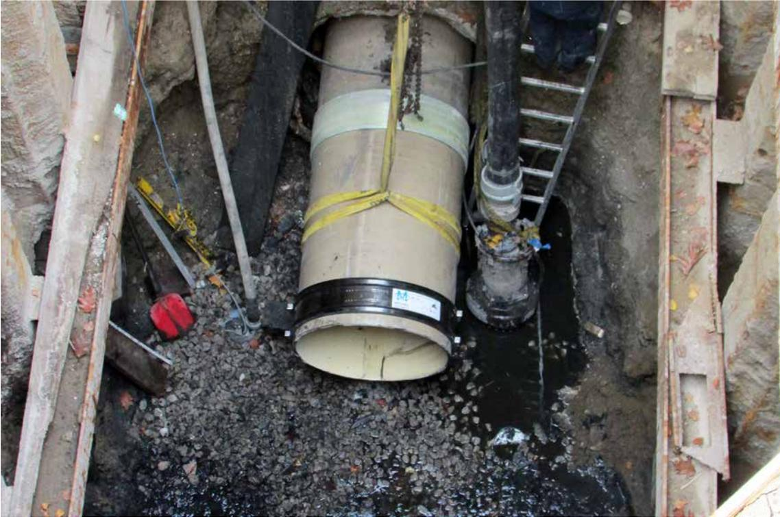
Vor dem Setzen des neuen Polymerbetonschachtes wird die Übergangskupplung Canada Plus MSC 830 auf das anzuschließende GFK-Passstück DN 800 geschoben.
